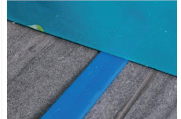
Bringen Sie Platte in Position und kontrollieren Sie den 3 mm Abstand zu allen festen Teilen. Zur Hilfe können Plastikklötzchen oder ähnliches verwendet werden. Danach drücken Sie die Platte gleichmäßig an.
